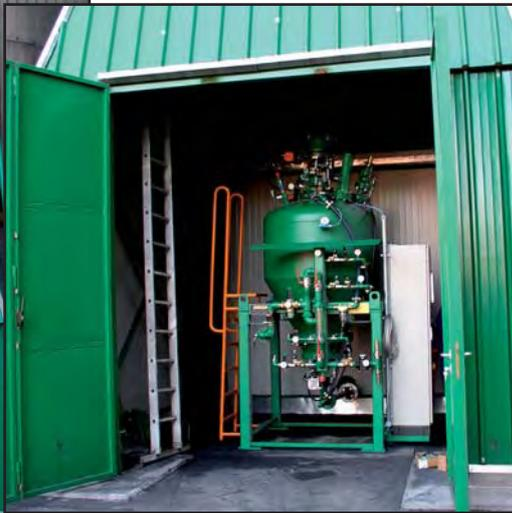
Injektionsanlage EDS unter Silo
